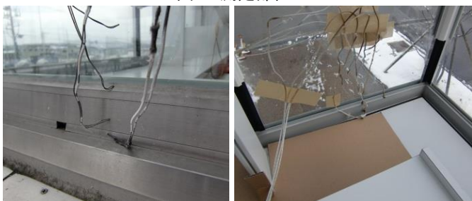
写真2 温度測定状況
